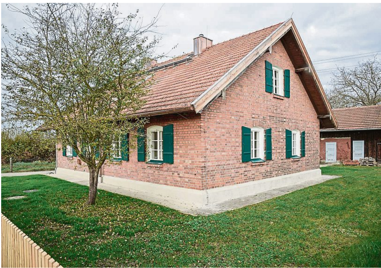
Das ehemalige Arbeiterwohnhaus bei der Versuchsstation Roggenstein wurde saniert. Das Dach wurde gedämmt, danach kamen die alten Ziegel wieder drauf. Der ursprüngliche Charakter sollte erhalten werden. FOTOS: GERHARD MEININGHAUS
